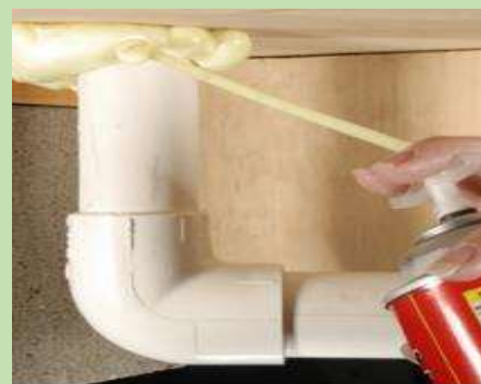
Applicazione di schiuma poliuretana
